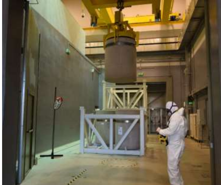
Figura 6: Operazioni di Caricamento al Deposito Temporaneo
