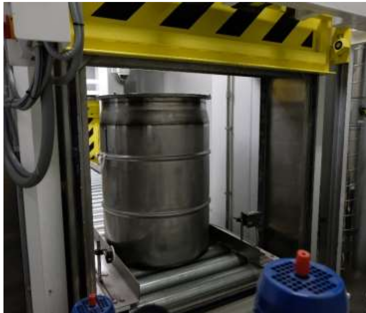
Figura 5: Manufatto contenente i Fanghi Condizionati
